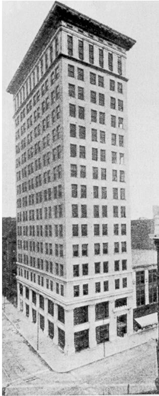
O *Ingalls Building* foi o primeiro arranha-céu construído em concreto armado, com 16 andares. Projeto da firma de arquitetura Elzner and Anderson teve a estrutura de concreto feita executada com o sistema de Ransome, utilizando lajes planas
