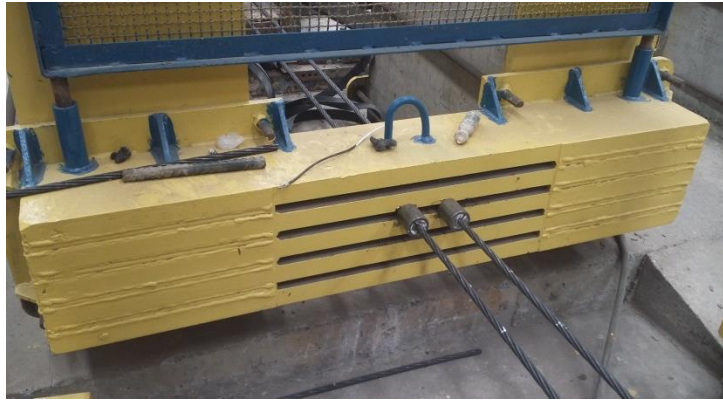
Figura 5.7 – Detalhe da fixação das cordoalhas na viga metálica da ancoragem ativa em pista de protensão. (Fonte: Marka Soluções Pré-fabricadas, Fotografia do Autor)
