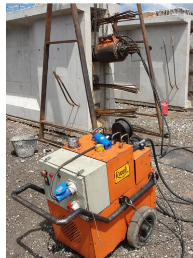
b) aplicação da protensão (estiramento) pelo conjunto cilindro e bomba hidráulica;
