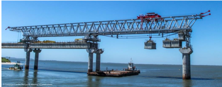
Figura 1.15 – Ponte Anita Garibaldi em fase de construção em Laguna/SC, com vãos em aduelas pré-moldadas protendidas. (Fonte: Berd - Bridge Engineering Research & Design, https://www.berd.eu/projectos/laguna )
