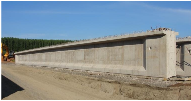
a) vista da viga;
