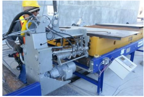
b) estiramento dos fios de protensão com equipamento específico, antes do lançamento do concreto na fôrma.
