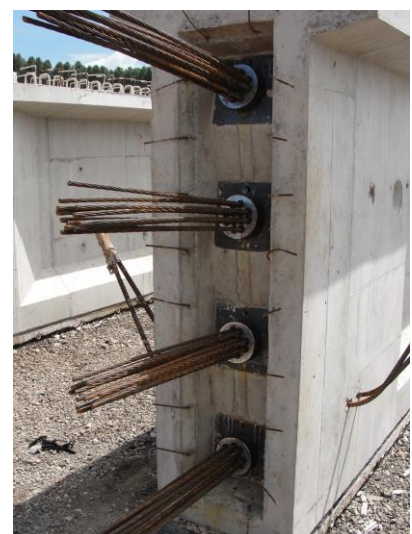
Figura 1.43 – Viga protendida pós-tensionada com ancoragem Rudloff para superestrutura de viaduto em rodovia. (Fotografias do Autor)
