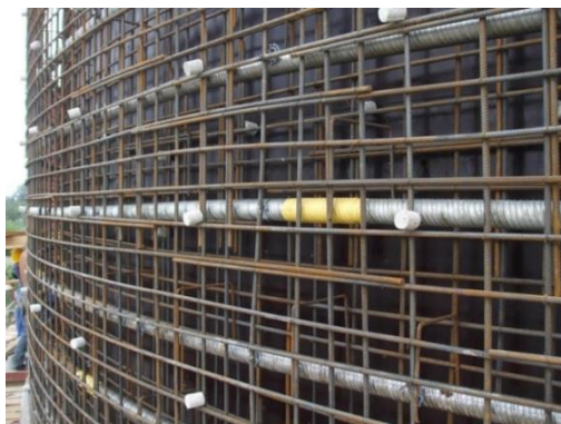
a) bainhas metálicas entre armaduras passivas;
