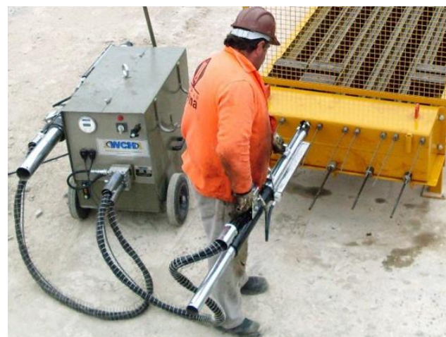
Figura 1.33 – Operação de estiramento de fio na ancoragem ativa de estrutura metálica de protensão. (Fonte: Weiler-C.Holzberger Ind. Ltda, http://wch.com.br )
