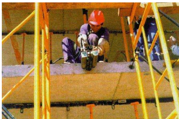
Figura 1.51 – Operação de estiramento de cordoalha engraxada. (Fonte: ArcelorMittal)
