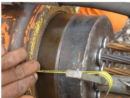
c) aferição do alongamento ocorrido no cabo de protensão em um estágio do estiramento;
