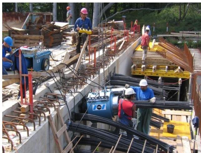
Figura 1.63 – Aplicação de protensão em cabos na pós-tensão. (Fonte: VSL, http://en.vsl.cz/post-tensioning )
