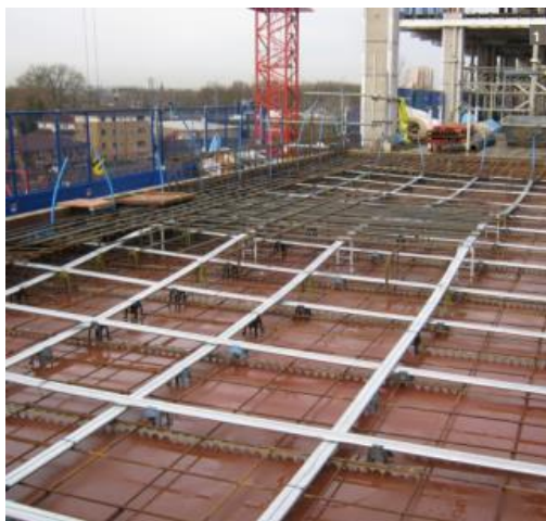
Figura 1.20 – Pavimento de edifício em laje protendida. (Fonte: Freyssinet, http://www.freyssinet.com )
