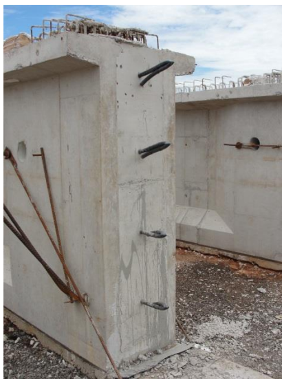
Figura 1.40 – Viga protendida pós-tensionada pré-moldada finalizada, para superestrutura de viaduto em rodovia. (Fotografias do Autor)
