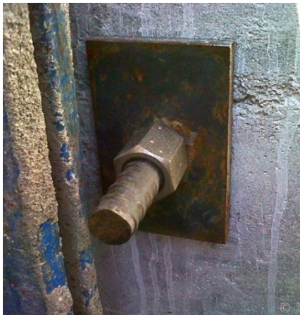
Figura 1.62 - Dispositivo para ancoragem de barra de protensão. (Fonte: Catálogo Dywidag [6] )
