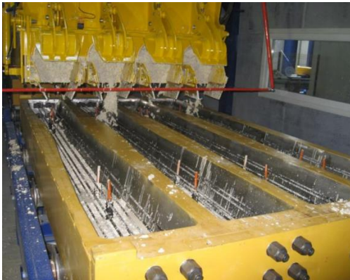
c) lançamento do concreto nas fôrmas metálicas, com os fios previamente estirados e ancorados na própria fôrma;
