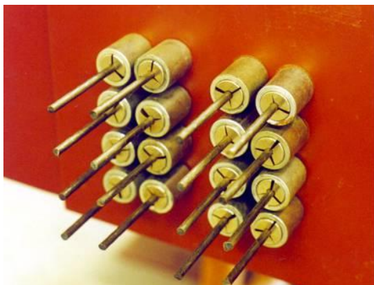
Figura 1.22 – Fixação de fios de protensão por meio de cunha tripartida embutida em orifício tronco-cônico da peça porta-cunha, em ancoragem passiva. (Fotografia do Autor)
