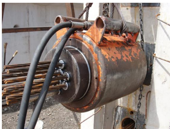
a) cilindro hidráulico posicionado para estiramento das cordoalhas;
