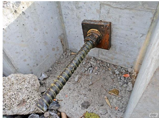
Figura 1.62 - Dispositivo para ancoragem de barra de protensão. (Fonte: Catálogo Dywidag [6] )
