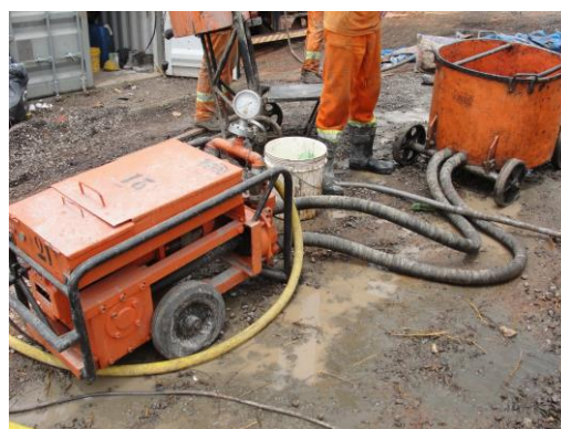
d) equipamentos para injeção de calda de cimento nas bainhas.
