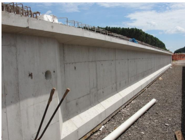
Figura 1.43 – Viga protendida pós-tensionada com ancoragem Rudloff para superestrutura de viaduto em rodovia. (Fotografias do Autor)
