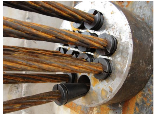
d) cunhas tripartidas inseridas em furos cônicos.
