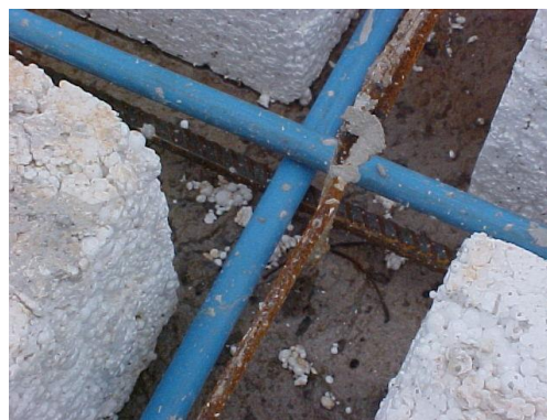
b) detalhe das armaduras no cruzamento de nervuras.
