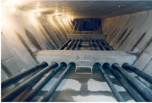
Figura 1.52 – Cabos de protensão externos em seção caixa de ponte. (Fonte: BBR VT International Ltd, http://www.bbrnetwork.com )
