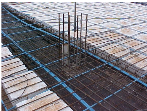
Figura 1.49 – Laje nervurada protendida com cordoalhas engraxadas. (Fotografias do Autor)
