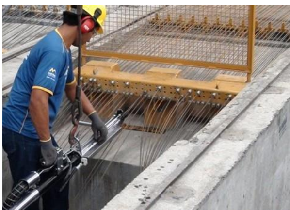
Figura 1.32 – Operação de estiramento de fio na ancoragem ativa de pista de protensão. (Fonte: Weiler-C.Holzberger Ind. Ltda, http://wch.com.br )
