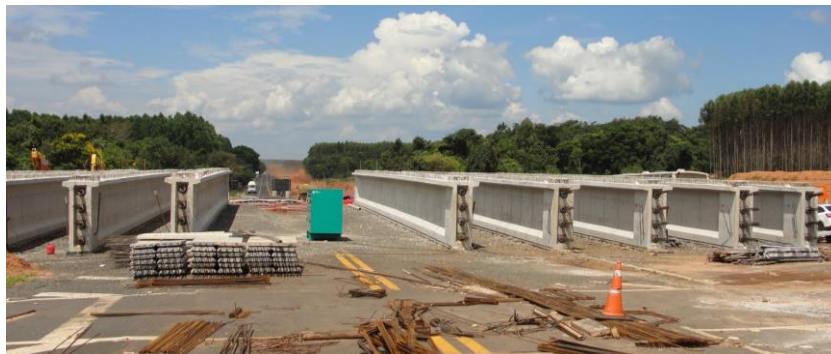
Figura 1.45 – Vigas protendidas pós-tensionadas pré-moldadas de canteiro. (Fotografia do Autor)
