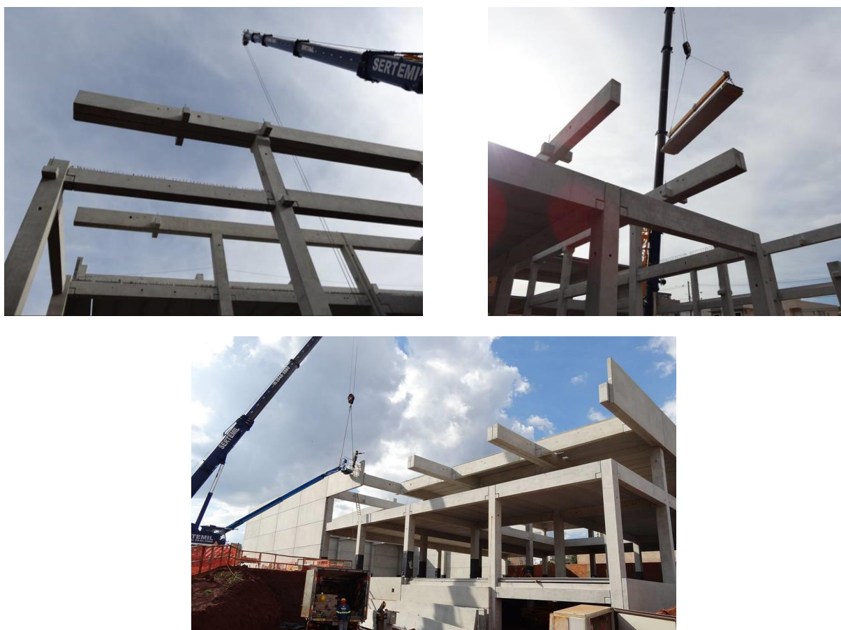
Figura 1.5 – Viga pré-moldada protendida de seção retangular, com vão em balanço, em edifício de três pavimentos. (Cortesia: Marka Soluções Pré-fabricadas, www.marka.ind.br )
