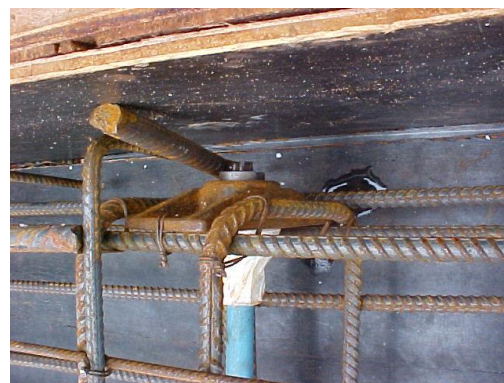
Figura 1.49 – Laje nervurada protendida com cordoalhas engraxadas. (Fotografias do Autor)
