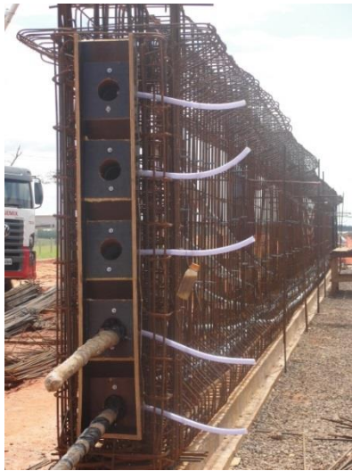
Figura 1.39 – Montagem das armaduras passivas e bainhas metálicas para confecção de uma viga pós-tensionada pré-moldada para superestrutura de viaduto em rodovia. (Fotografias do Autor)
