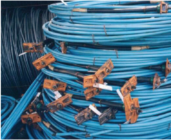
Figura 3-5 Estoque de cabos cortados e enrolados, com ancoragens pré-blocadas, devidamente etiquetados. Amarração com arame cabo a cabo. Para amarração de conjuntos de cabos deve ser usada cinta protetora para não danificar a bainha plástica
