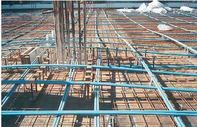
Figura 2-8 Cabos posicionados nas fôrmas em faixas e distribuídos regularmente
