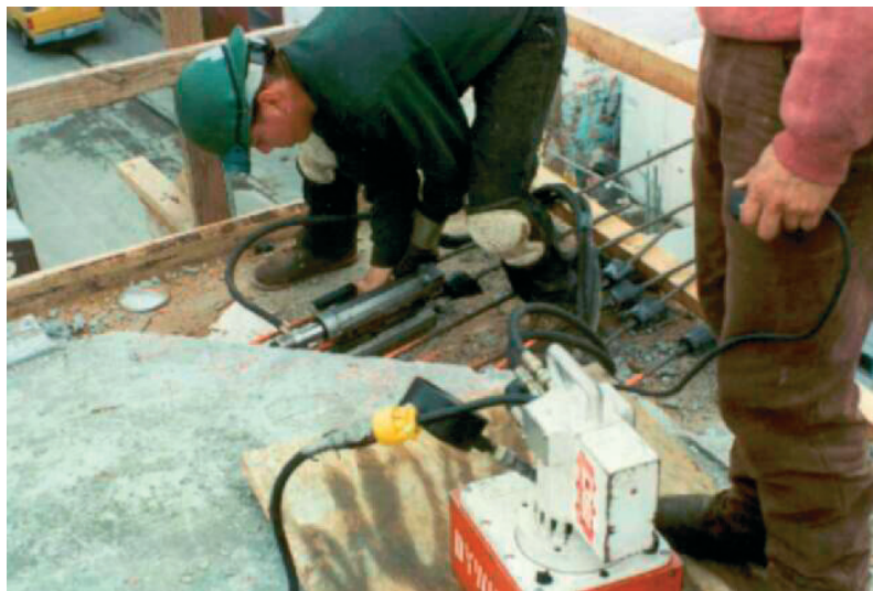
Figura 2-10 Tracionamento dos cabos
