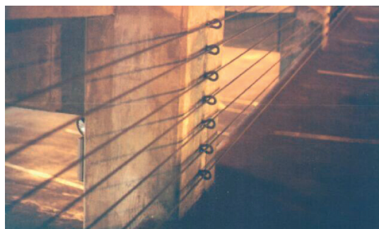
Cabos barreira colocados em olhais na borda do pilar
