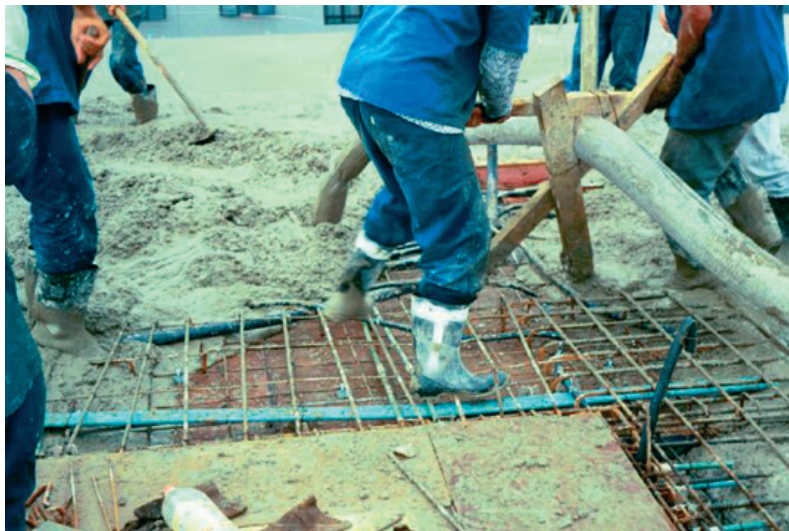
Figura 2-9 Lançamento do concreto
