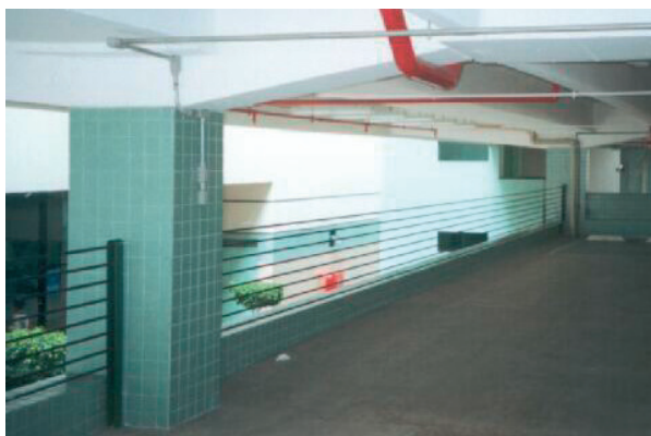
Cabos barreira no Shopping Center Iguatemi de Fortaleza - CE
