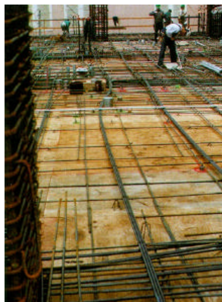
As cordoalhas fazem uma curva, para se desviarem de obstáculo
