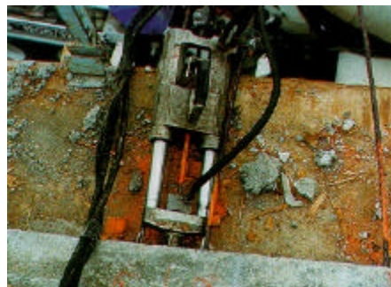
Macaco hidráulico de dois pistões efetua a protensão
