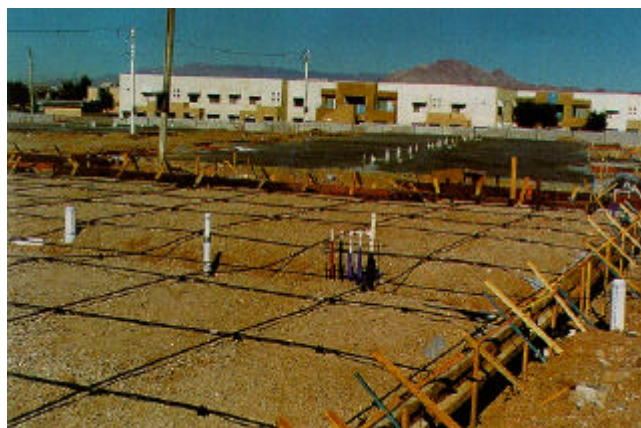
Preparação de radier, em concreto protendido, durante a construção de prédios de três andares nos EUA (no fundo, área já concretada)
