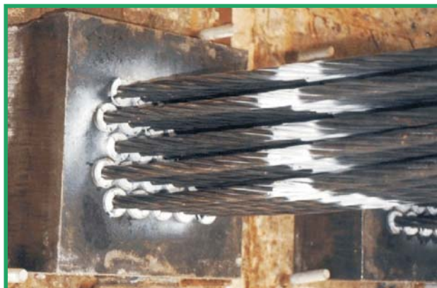
Foto 8: pintura de cordoalhas, para medição de alongamentos
