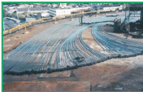
Foto 4: pré-montagem de cabos engraxados
