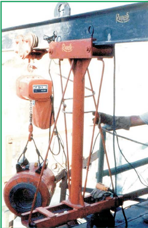
Foto 2: instrumentos para a suspensão de equipamento de protensão
