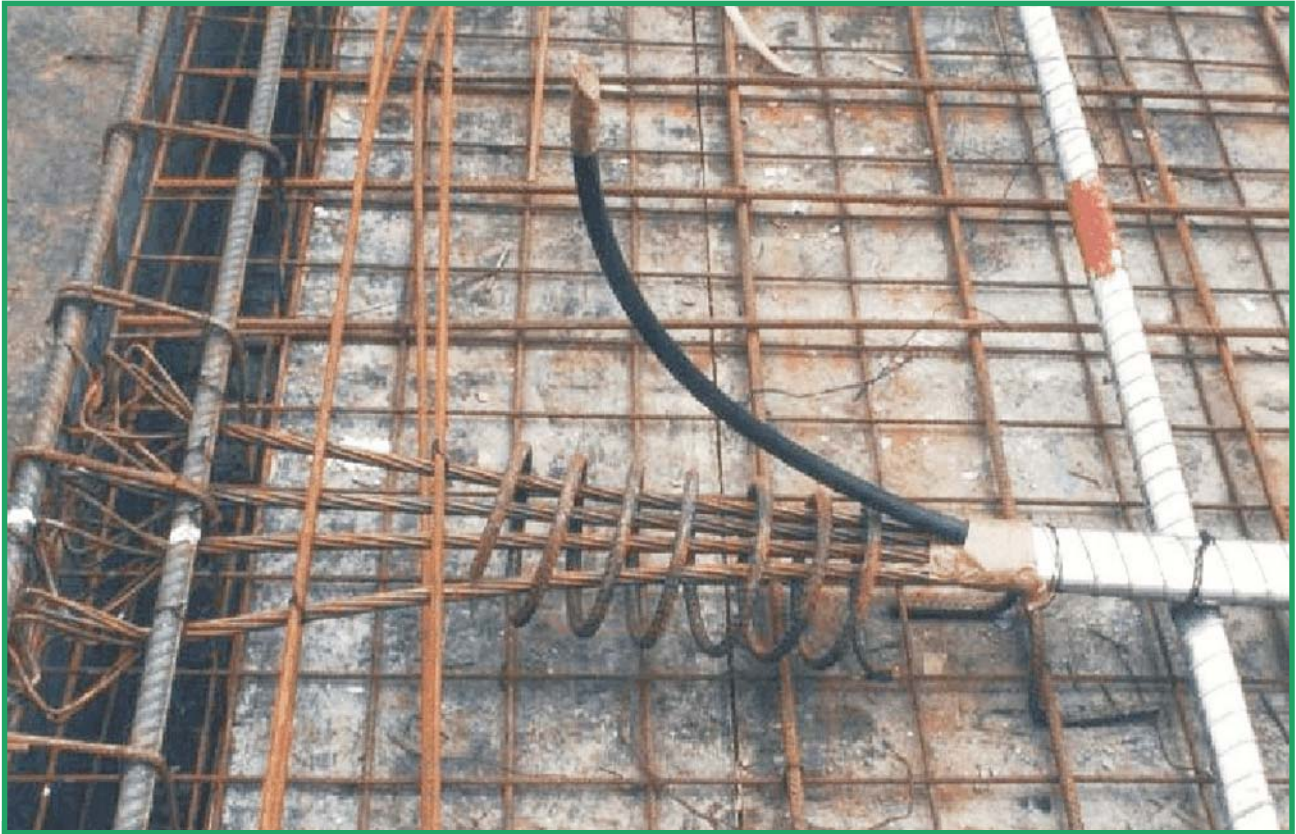
Foto 6: detalhe de purgador e armadura de fretagem junto à ancoragem
