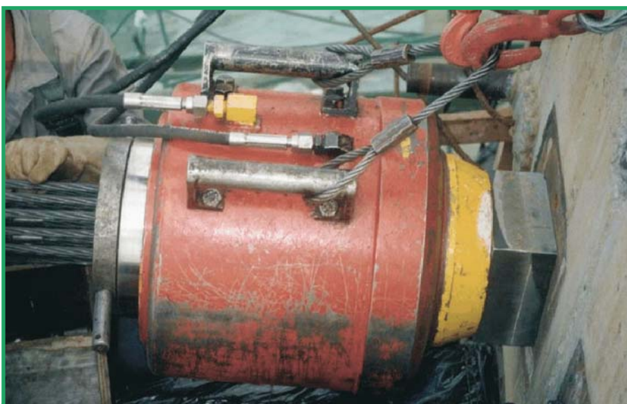
Foto 7: operação de protensão
