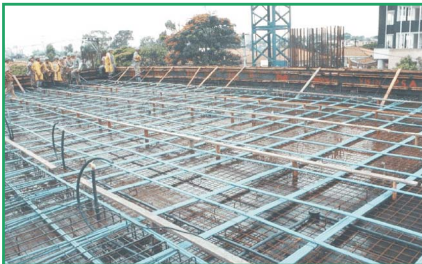
Foto 5: colocação dos cabos em obra
