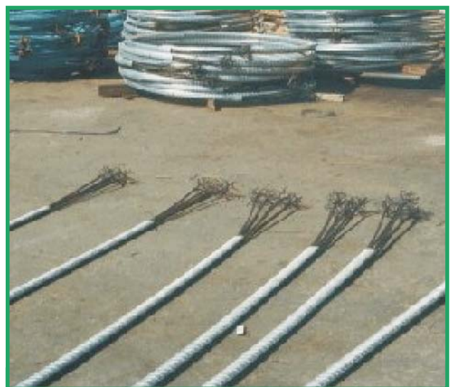
Foto 3: pré-montagem de cabos aderentes
