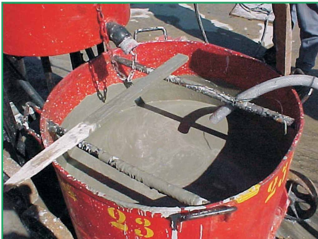
Foto 9: operação de injeção dos cabos
