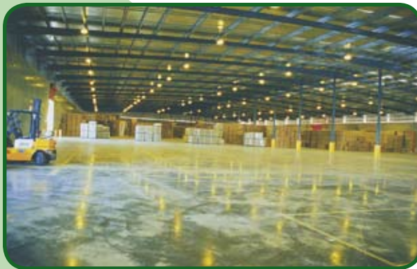
Piso protendido em Victoria, Austrália. Protensão de pisos e pavimentos possibilita espessuras de concreto reduzidas, poucas juntas e estruturas impermeáveis
