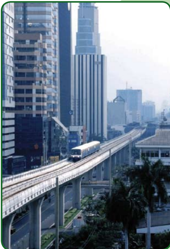
Sistema de transporte coletivo, Bangkok, Tailândia. Geometrias complexas, sobrecargas elevadas, grandes vãos, flechas reduzidas e longa vida útil.
