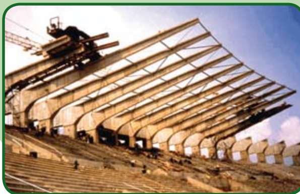
Cobertura em estádio de Chiangmai, Tailândia. A tecnologia do concreto protendido possibilita a execução de projetos arquitetônicos e estruturais arrojados e personalizados
