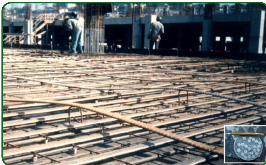
Fig. 2 – Execução de laje com protensão aderente; no detalhe, seção transversal de um corpo de prova de ensaio de aderência
