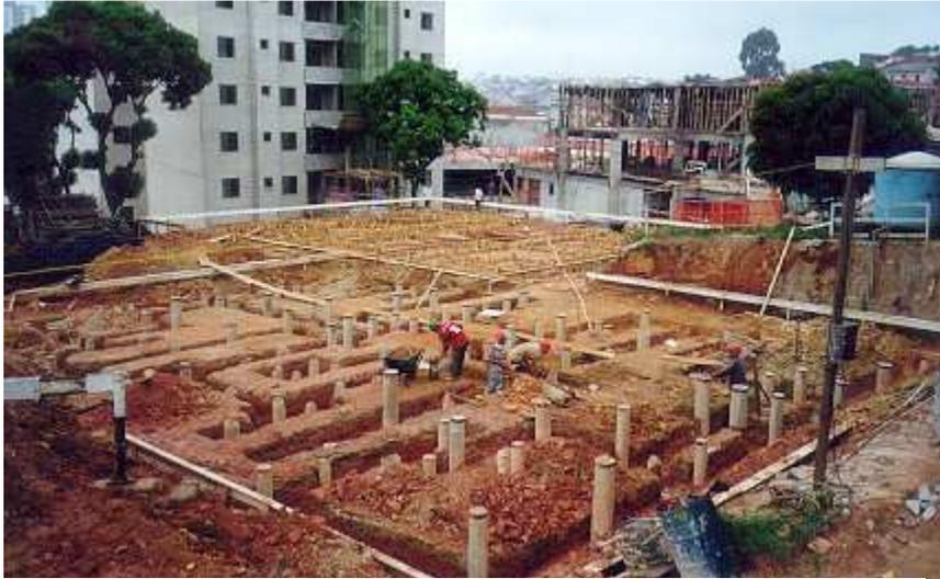
**Figura 1.1.10 – Estaqueamento – distribuição uniforme de carga**
