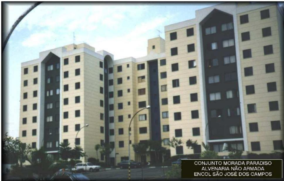
Figura 1.1.7 – Conjunto de Alvenaria não Armada - prédios com 8 pavimentos
