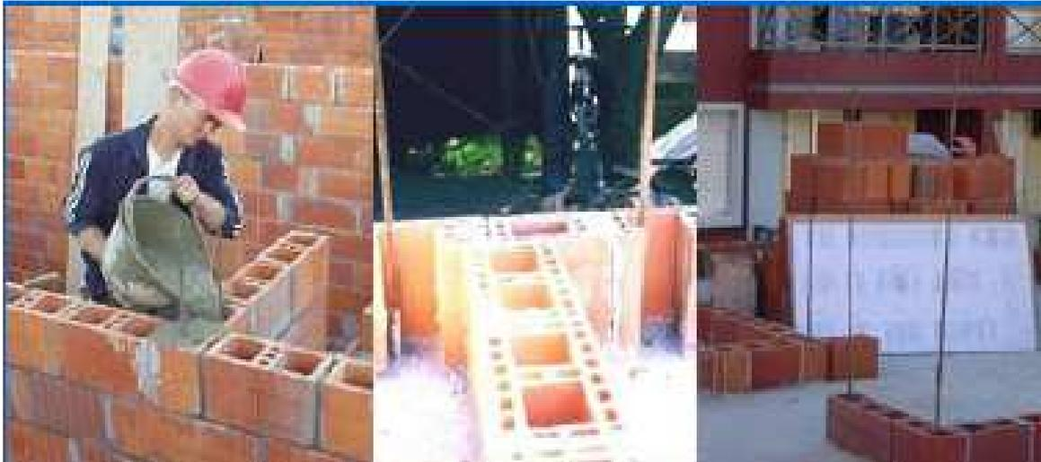
Figura 1.3.3 – Grouteamento de paredes de alvenaria
