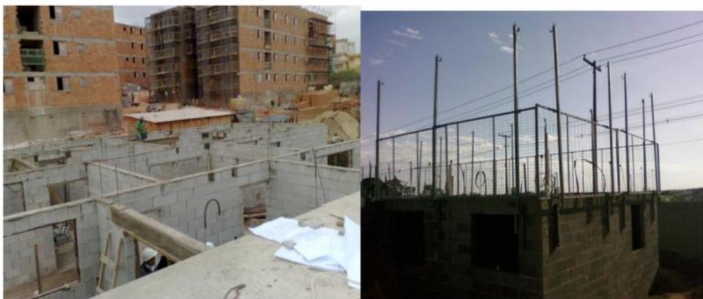
**FOTO 12. Cinta de respaldo concretada antes da colocação da laje pré moldada.**
