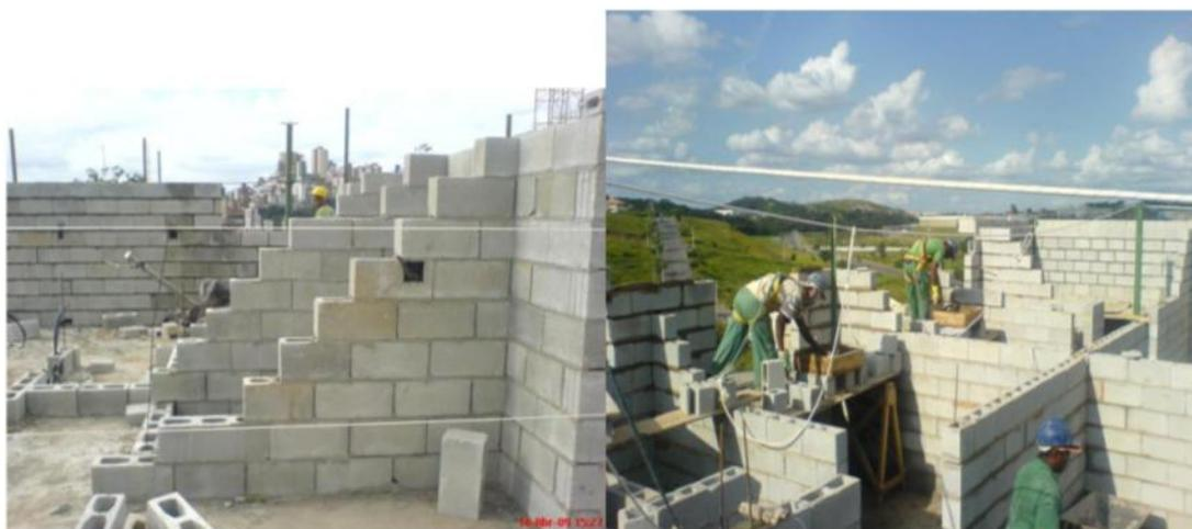
FOTO 10. Interrupção de alvenaria em forma de castelo
