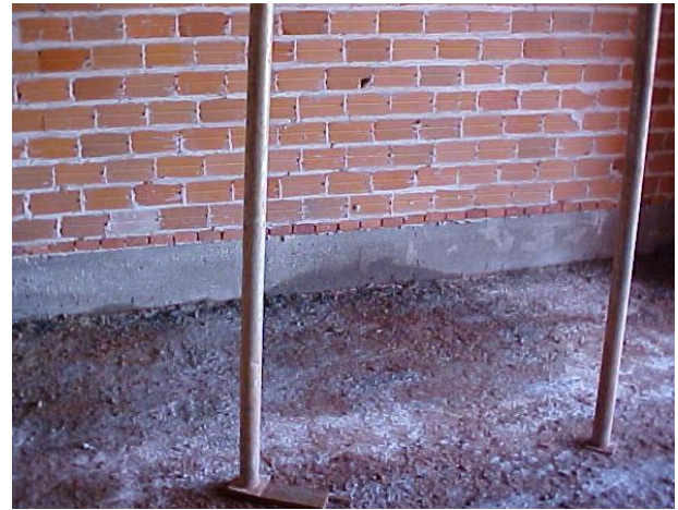
Figura 4.21 – Viga invertida na base de uma parede.
