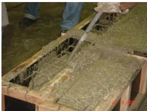
Figura 1.1 – Preenchimento de fôrma com concreto e adensamento interno com vibrador de agulha. (FONTE: ARQUEZ, 2010).
