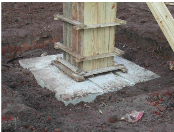
Figura 4.39 – Blocos de fundação já concretados.
