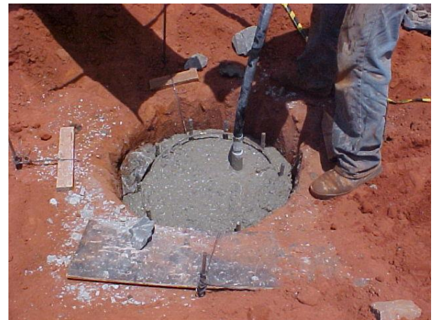
Figura 4.38 – Lançamento do concreto no tubulão e adensamento do concreto do topo do fuste.
