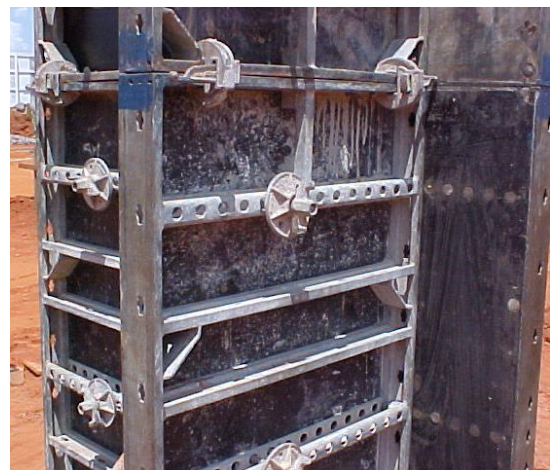
Figura 4.31 – Pilar sendo concretado e detalhe da fôrma.
