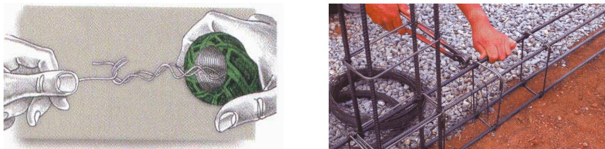
Figura 2.32 – Arame duplo recozido (FONTE: Arcelor-Mittal).
