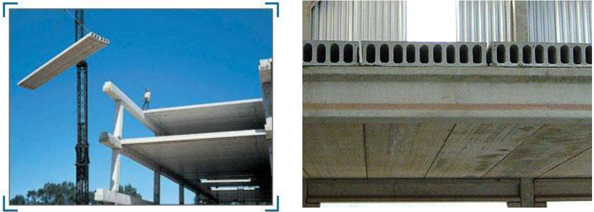
Figura 4.16 – Laje alveolar de Concreto Protendido (FONTE: TATU PRÉ-MOLDADOS, 2004).
