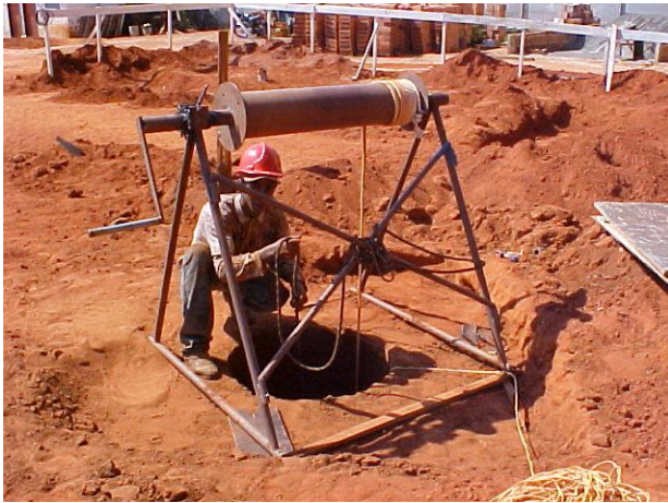
Figura 4.37 – Tubulões sendo escavados manualmente e com equipamento.
