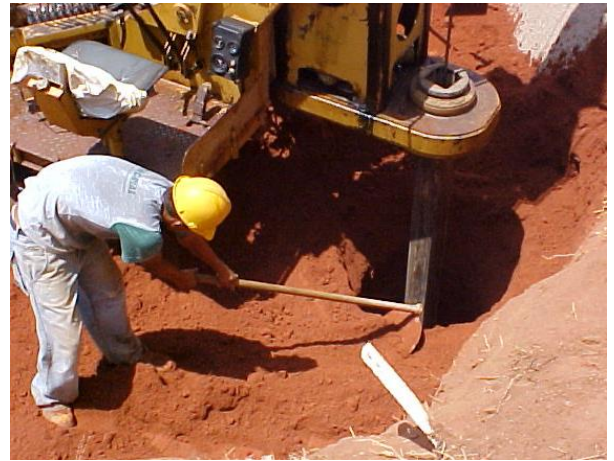
Figura 4.37 – Tubulões sendo escavados manualmente e com equipamento.
