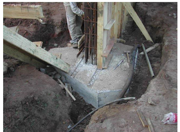
Figura 4.39 – Blocos de fundação já concretados.
