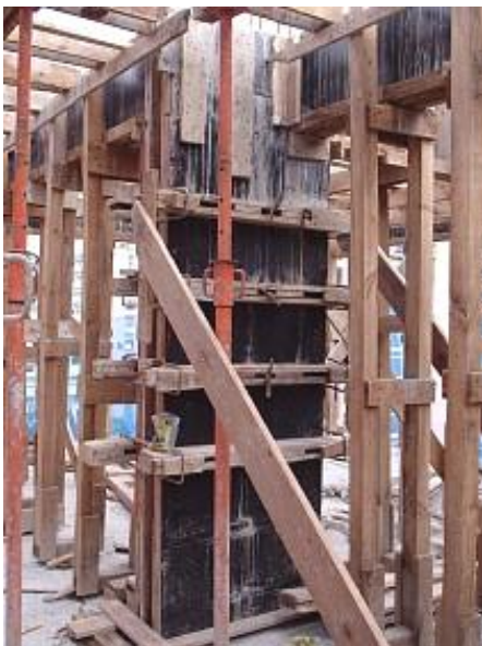
Figura 4.28 – Montagem de um pilar e detalhe da fôrma.
