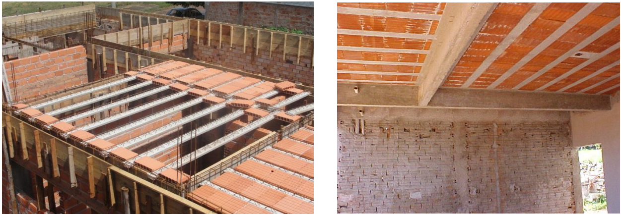
Figura 4.23 – Exemplos de vigas em sobrado residencial.
