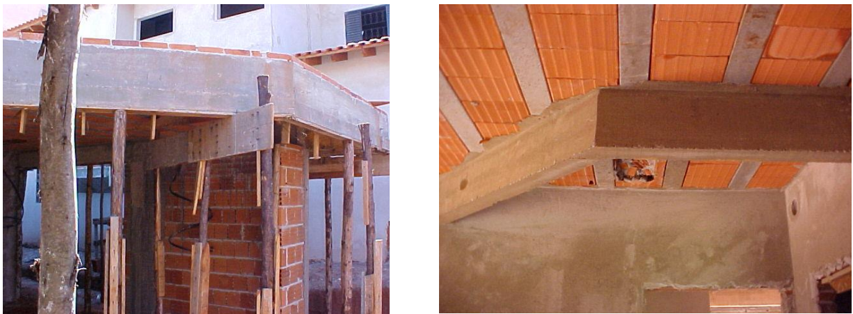
Figura 4.24 - Vigas com mudança de direção, caso onde os momentos de torção devem ser considerados.
