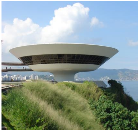
Figura 4.4 – Exemplo de estrutura com superfícies em casca.
