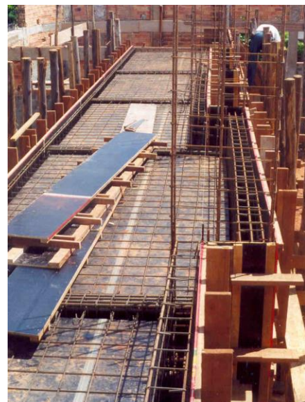
Figura 4.7 – Lajes maciças sendo concretadas e em construção.
