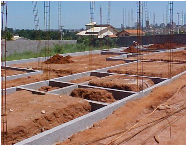
Figura 4.20 – Vigas baldrame para apoio das paredes da residência.
