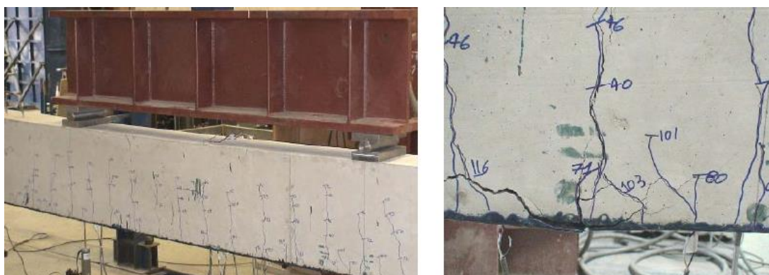
Figura 1.8 – Fissuras em uma viga após ensaio experimental em laboratório (FONTE: FERRARI, 2007).
