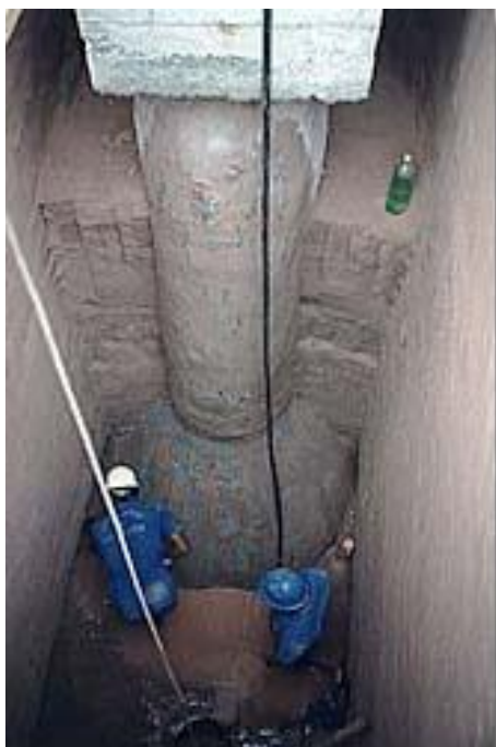
a) tubulão em vistoria;
