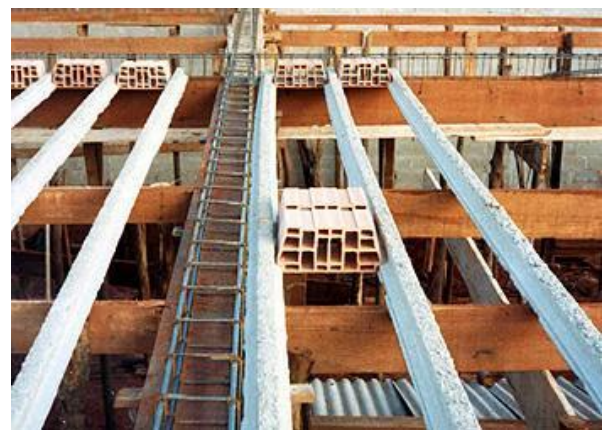
Figura 4.15 – Laje pré-fabricada com nervura protendida.
