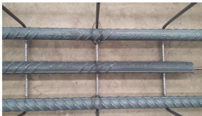
b) detalhe da amarração de barra CA-50 S com arame recozido (Fonte: Marka Pré-Moldados - Fotografia do Autor).
