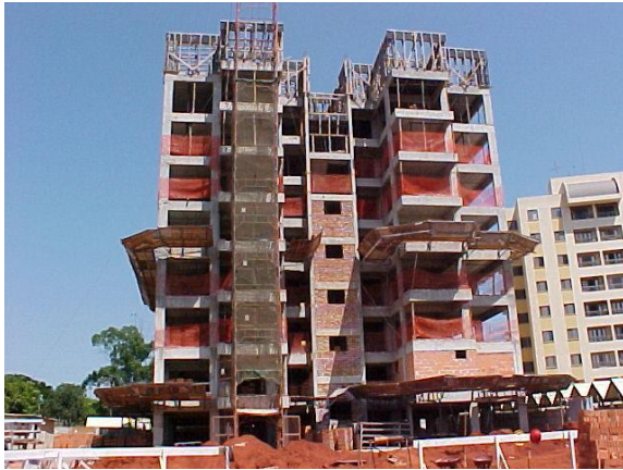
Figura 4.27 – Pilares em um edifício de múltiplos pavimentos.
