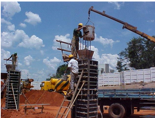
Figura 4.31 – Pilar sendo concretado e detalhe da fôrma.
