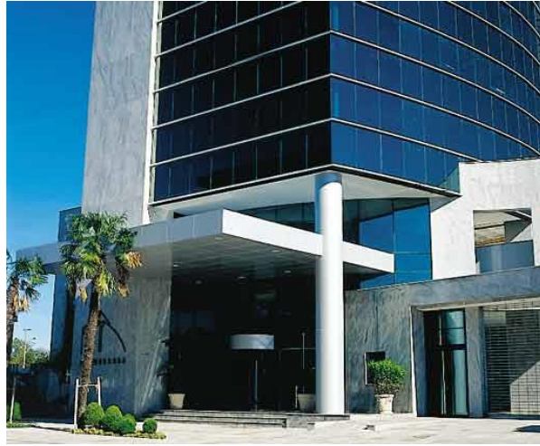
Figura 4.26 – Pilar na fachada de edifício.
