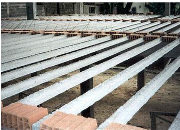
Figura 4.15 – Laje pré-fabricada com nervura protendida.
