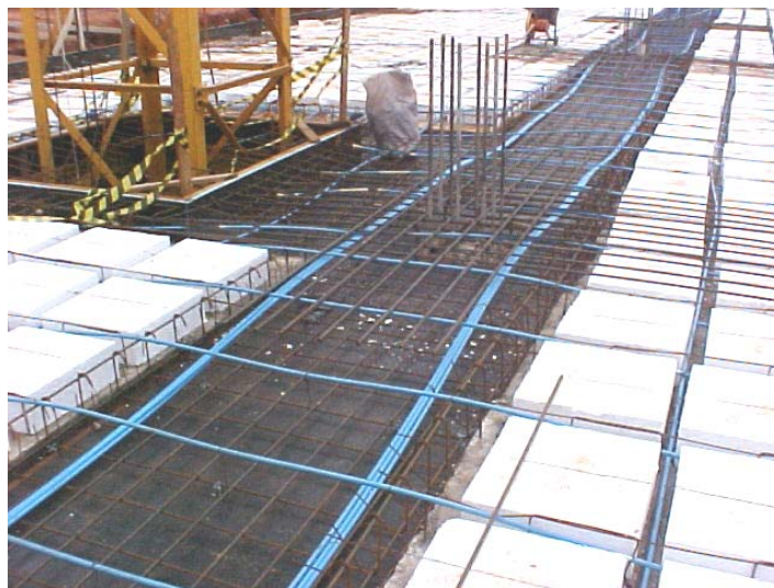
Figura 2.36 – Distribuição das armaduras de protensão de uma viga-faixa.
