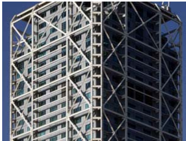
Figura 3.15 – Hotel Arts (Barcelona) - Contraventamento metálico em “X”.
