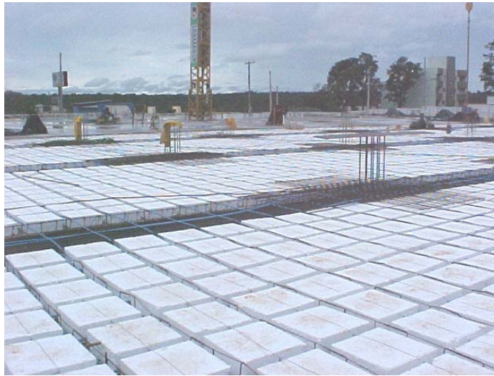
Figura 2.23 - Blocos EPS distribuídos sobre as fôrmas.
