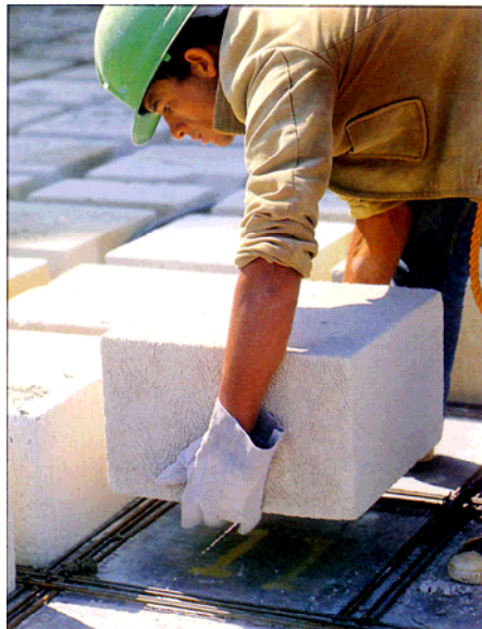
Figura 2.22 – Enchimento com concreto celular autoclavado.
