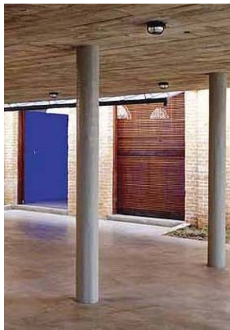
Figura 2.15 – Laje lisa apoiada diretamente nos pilares.
