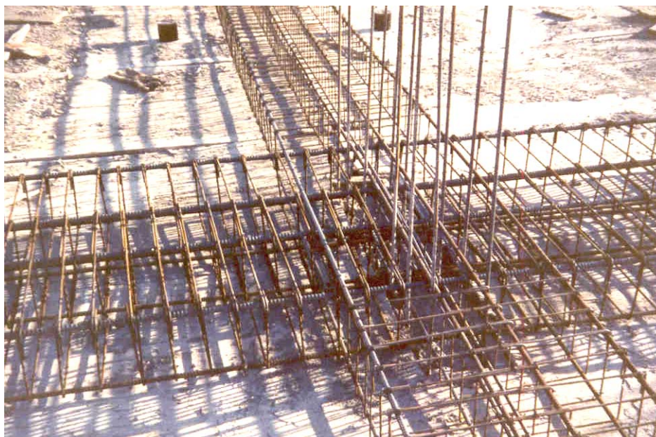
Figura 2.34 – Armaduras do cruzamento de duas vigas-faixa.
