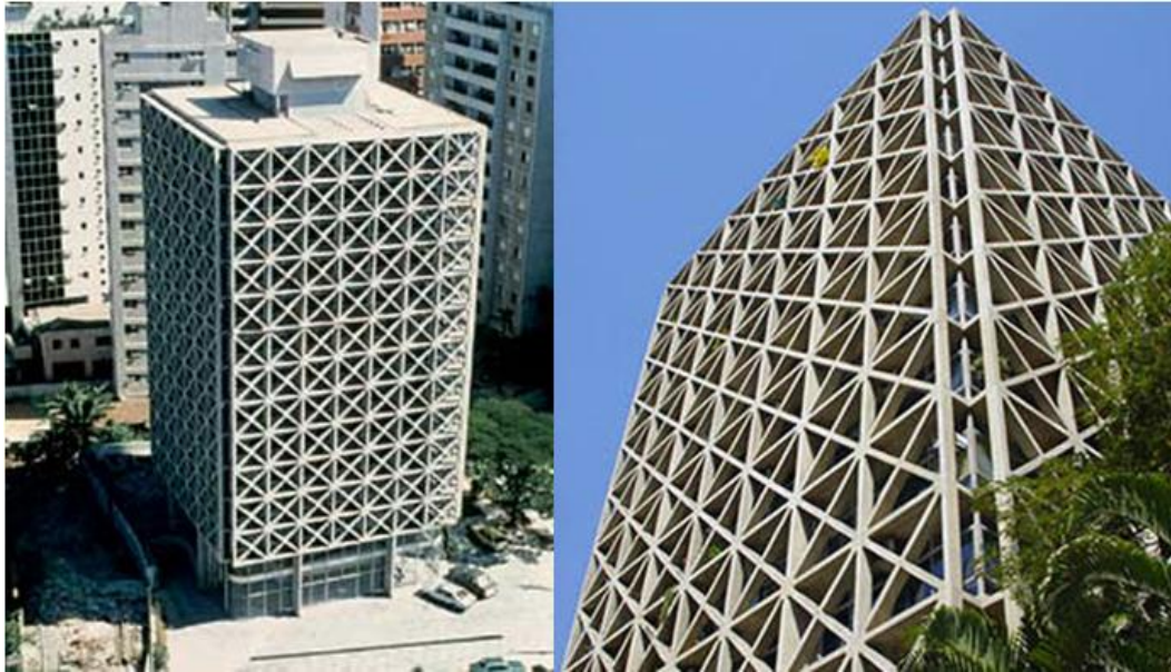
Figura 3.14 – Edifício Acal (São Paulo) - Contraventamento em “X” de Concreto Armado.
