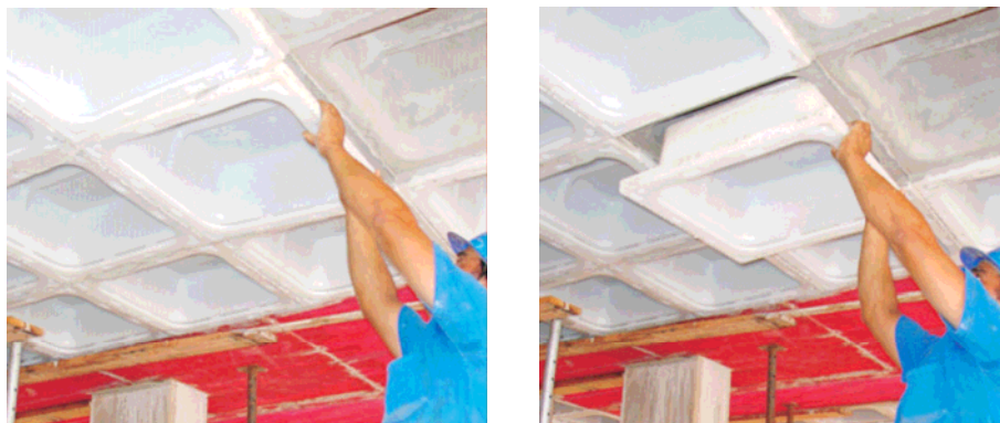
Figura 2.20 – Retirada dos caixotes de plástico.
