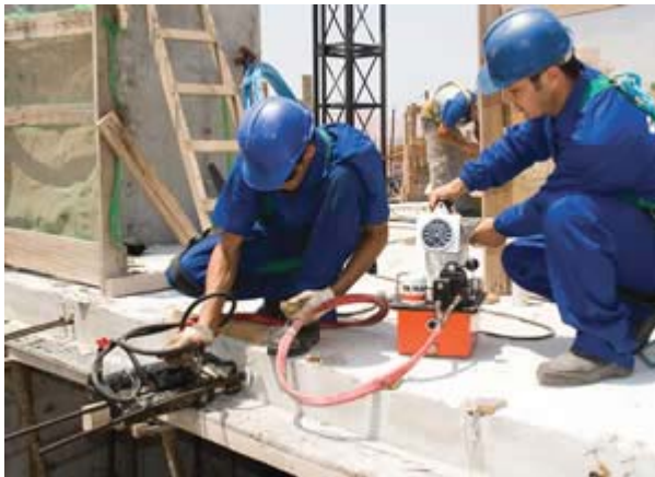
Figura 2.41 – Ancoragem ativa: a) aplicação da protensão com macaco hidráulico Portátil; b) ancoragem após a retirada do macaco (ESQUIPE DE OBRA 1 ).
