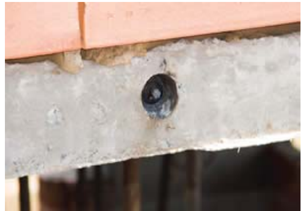
Figura 2.41 – Ancoragem ativa: a) aplicação da protensão com macaco hidráulico Portátil; b) ancoragem após a retirada do macaco (ESQUIPE DE OBRA 1 ).
