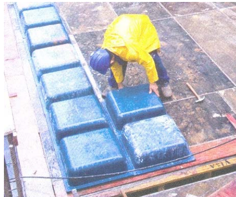
Figura 2.17 – Distribuição dos caixotes sobre o tabuleiro (EQUIPE DE OBRA 1 , 2007).
