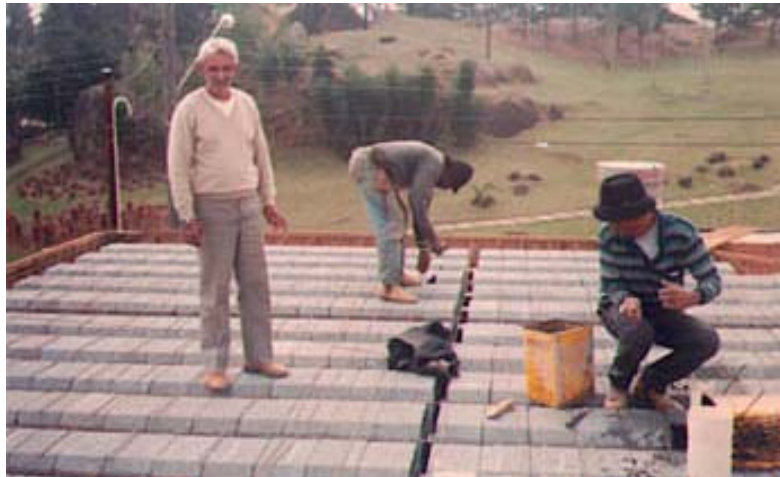
Figura 2.55 – A resistência dos blocos facilita a execução. (FIGUEIREDO FILHO e CARVALHO, 2004).
