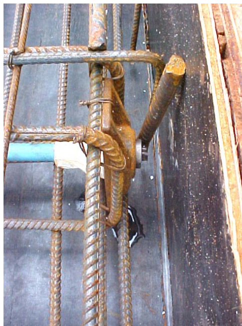
Figura 2.39 – Acomodação da ancoragem passiva na fôrma.
