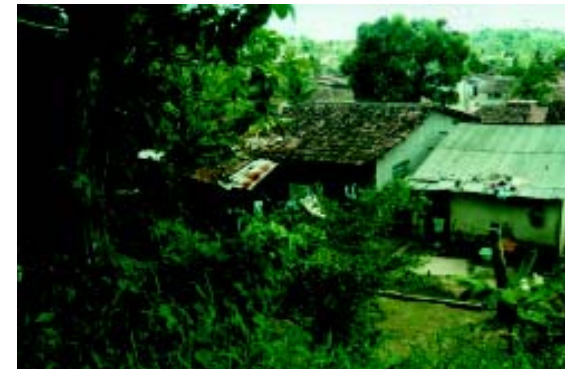
ÁRVORE na BORDA do TALUDE
