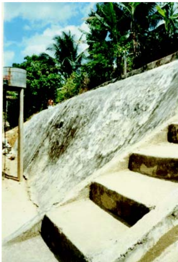
REVESTIMENTO CIMENTADO Camaragibe
