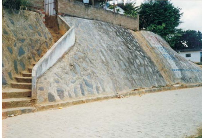
TALUDE REVESTIDO COM PEDRA DE FACE
