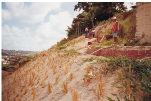
RETALUDAMENTO e REVESTIMENTO VEGETAL em ENCOSTA
