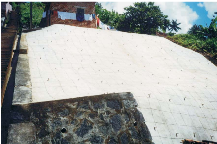
REVESTIMENTO COM TELA ARGAMASSA Camaragibe
