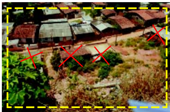
DETALHE Moradias em Risco ao Pé do Colúvio
