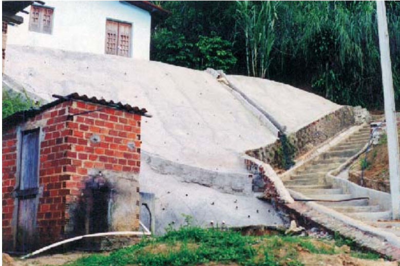
REVESTIMENTO COMPLETO com DRENAGEM Córrego do Boleiro, Recife
