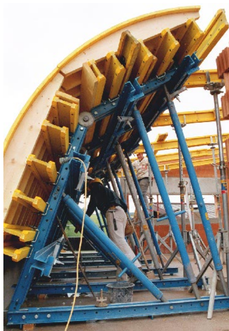
Obra: Novo edifício Candido, Saalfelden
