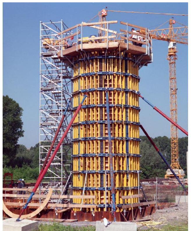
Obra: Travessia do Reno em Ilverich, Meerbusch
