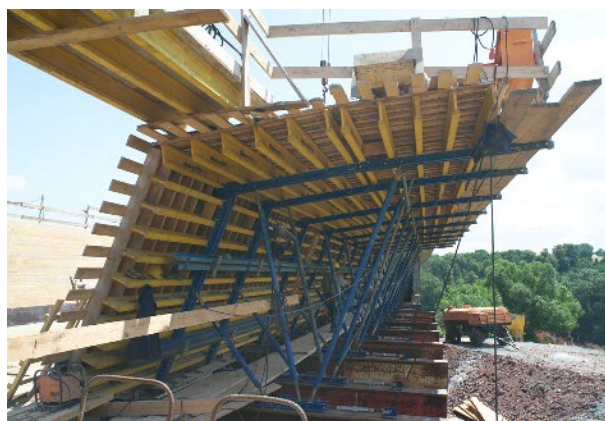
Obra: Ponte sobre o Gebergrund, Alemanha
