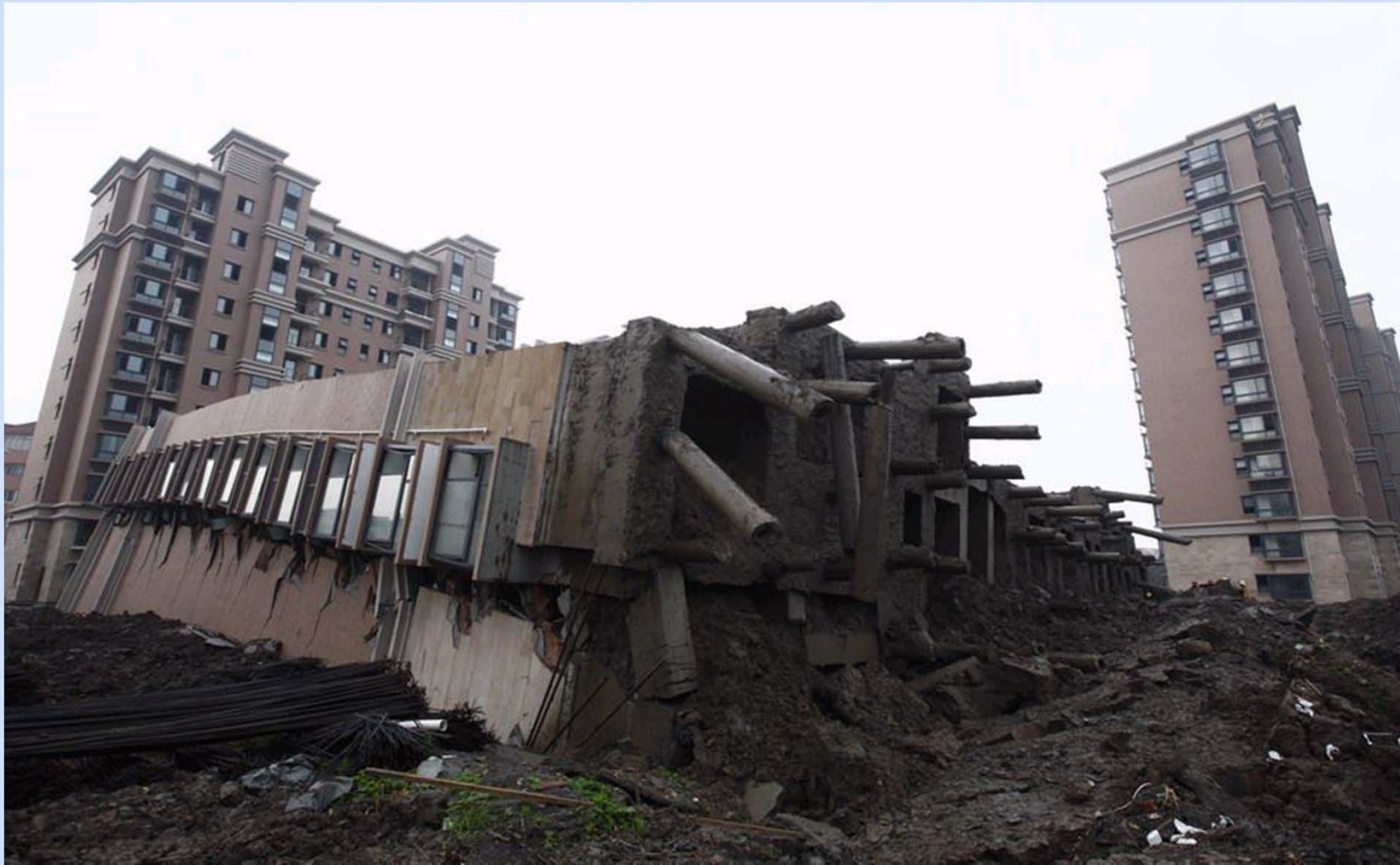
RUPTURA DE EDIFICIO NA CHINA
