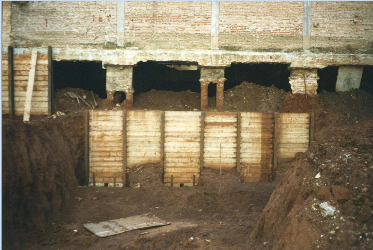
ESCAVAÇÃO COM DESCONFINAMENTO DAS FUNDAÇÕES DO PRÉDIO VIZINHO
