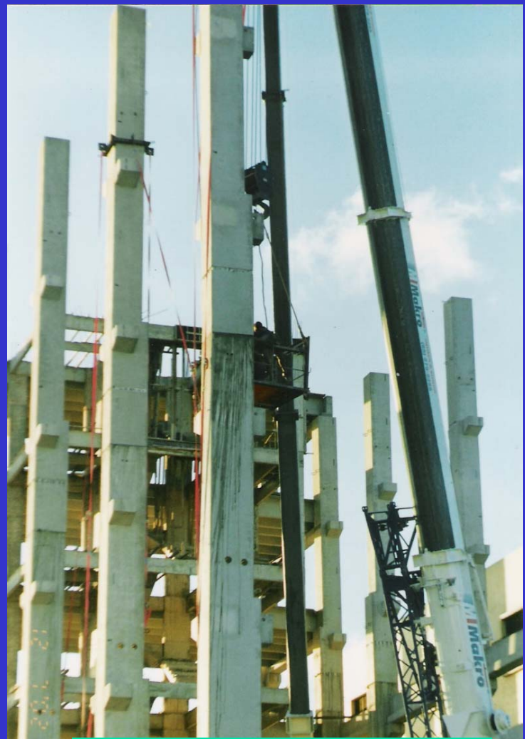
Montagem de Pilares
