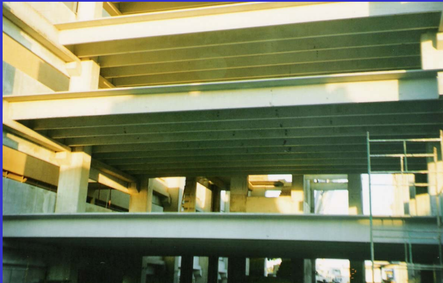
Montagem das Lajes TT
