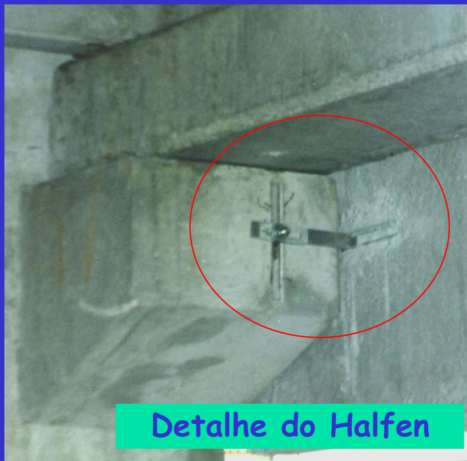
Apoio Vertical do Painel
