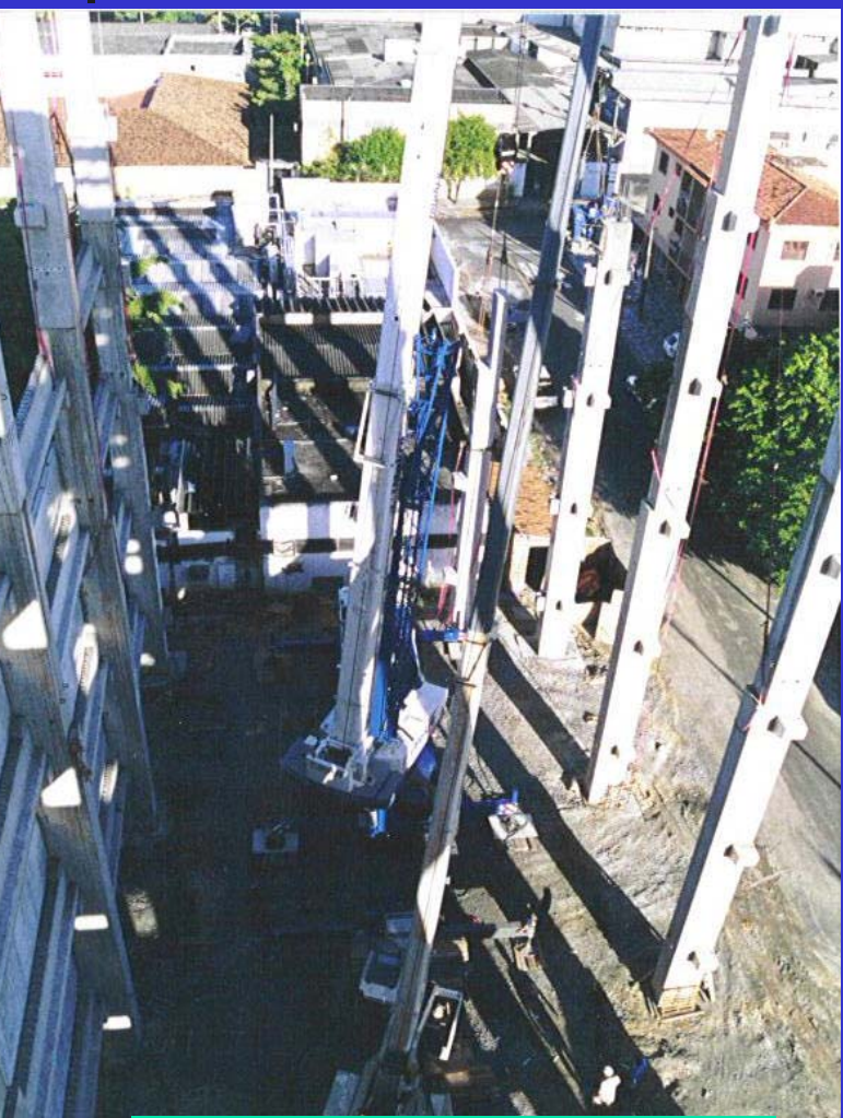
Montagem de Pilares
