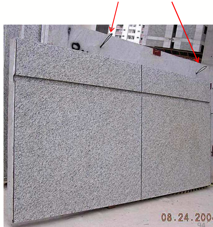
Alça produzida com Cabo de aço ( alma flexível) + armaduras.
