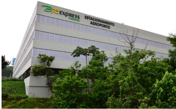
(ESTACIONAMENTO – Guarulhos SP)
