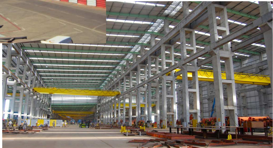
Estaleiro Atlântico Sul Suape/PE
