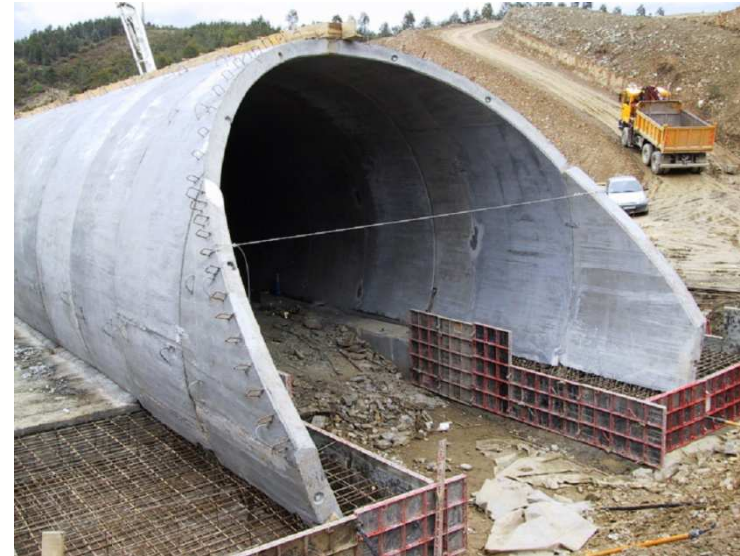
Túneis e Revestimentos
