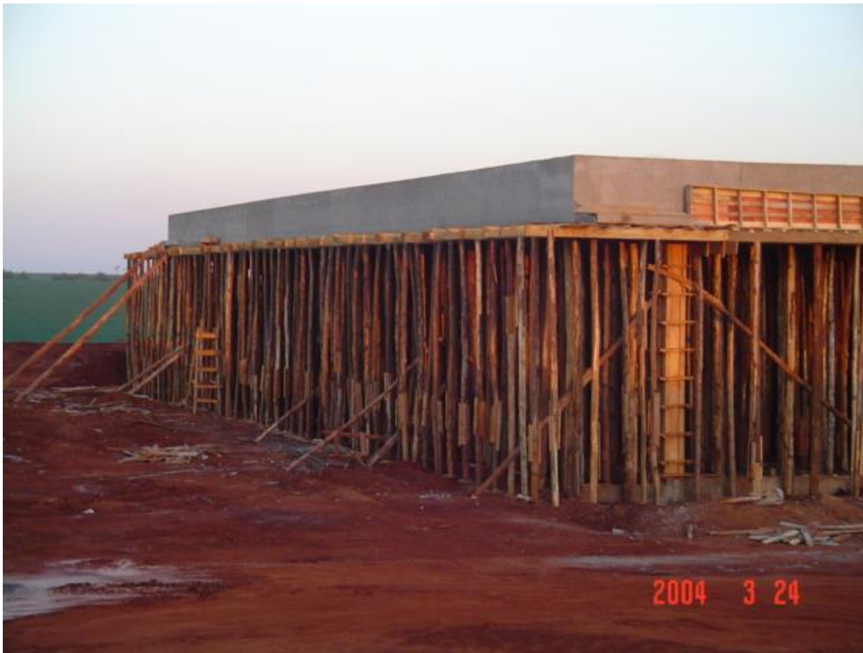
Estrutura Moldada “in loco”
