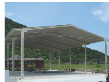
GALPÃO EM GUARUJÁ
