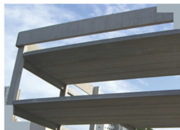
Lajes e painéis de fachada
