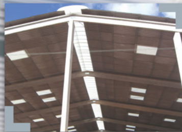
Domus e telhas de fibrocimento
