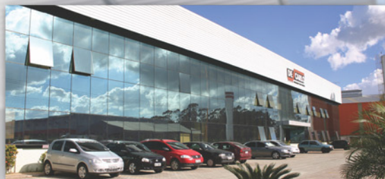
Pele de vidro com fechamento metálico horizontal
