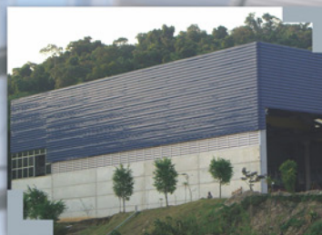
Painel de fechamento com telhas pré-pintadas e venezianas
