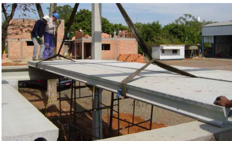
Figura 2 - Montagem da Laje Alveolar
