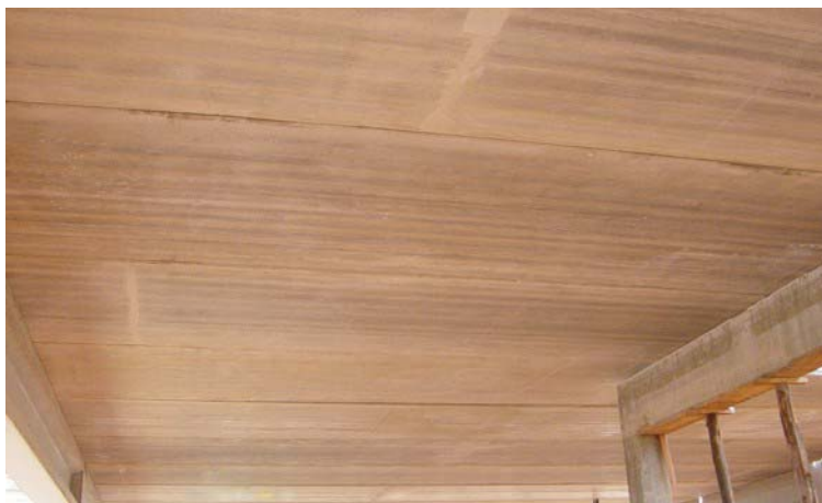
Figura 5 – Acabamento inferior da laje Alveolar
