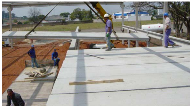
Figura 3 – Exemplo de montagem com redução de mão-de-obra
