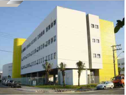
COLÉGIO ENERGIA - CRICIÚMA/SC
